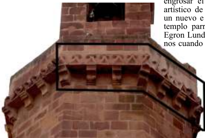
Fig. 4: Vista actual de la zona superior de la torre de campanas del templo de La Encarnación en la que se puede apreciar las reparaciones posteriores en la zona que correspondía a la caja del mecanismo del reloj. (Ilustración del autor)
