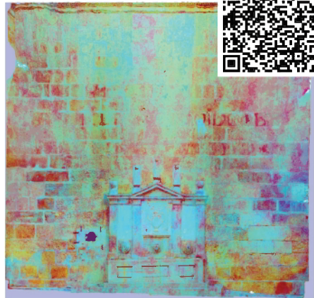
Fig. 5. Modelo 3 realizado sobre la fuente monumental situada entre la Puerta del Perdón y la Puerta de San Jerónimo. Arriba fotografía sin análisis de imagen y abajo con análisis del filtro LRE. (Fuente: Ilustración de los autores)
