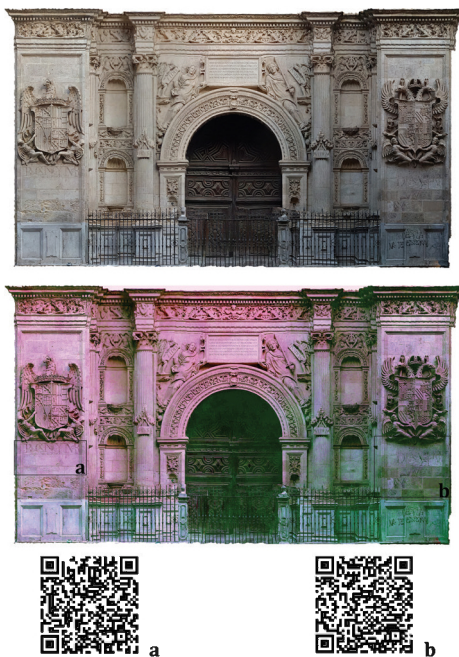
Fig. 3. Modelo 1 ubicado en la Puerta del Perdón en la que se han identificado vítores en su lateral izquierdo y derecho. Arriba fotografía sin análisis de imagen y abajo con análisis del filtro LRE. (Fuente: Ilustración de los autores)
