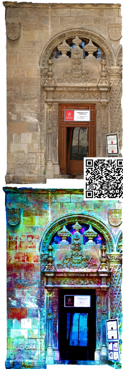
Fig. 12. Modelo 10 ubicado sobre la entrada actual de acceso a la Capilla Real. Arriba fotografía sin análisis de imagen y abajo con análisis del filtro RGB. (Fuente: Ilustración de los autores)
