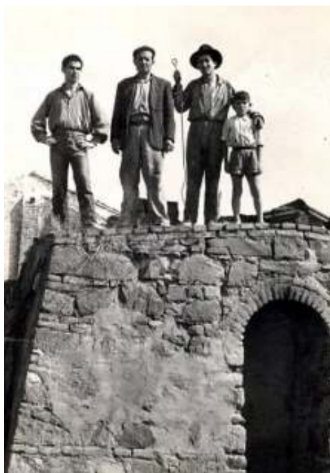
Fig. 5. Alfareros posando sobre el horno de la alfarería de “Campanas” en 1963. La arista izquierda de la construcción, nos informa de la estructura troncopiramidal de la misma. En la pared frontal se abre la puerta de carga (Fuente: Colección particular)
