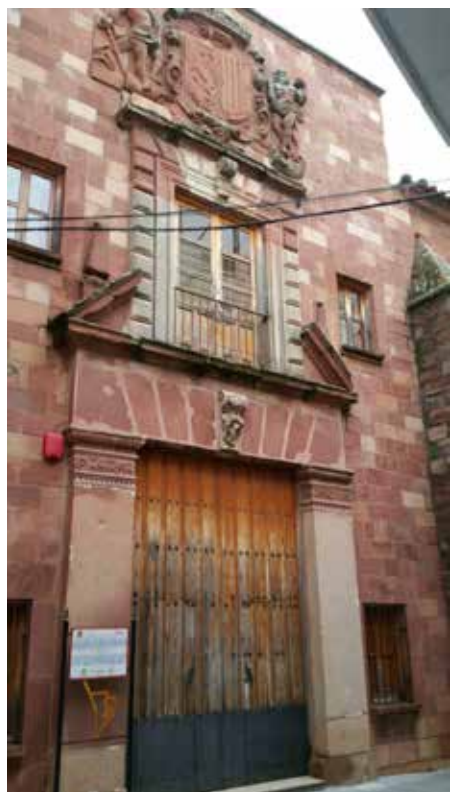
Fig. 48. Fachada antes. (Fuente: Fotografía de los autores)
