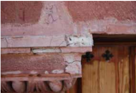
Fig. 23. Mortero de junta de sillares que en muchos casos cubren la superficie original. (Fuente: Fotografía de los autores)
