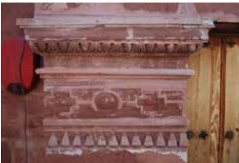
Fig. 22. Capitel de la pilastra están realizados con cemento y después policromados, lo vemos en las zonas faltantes. Presentan faltas de material, grietas, fisuras, restos de resinas plásticas, faltas de reintegración cromática. (Fuente: Fotografía de los autores)
