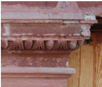
Fig. 29. Pruebas de mortero entonado con pigmentos naturales de la zona. Ejemplo de zona de reintegración volumétrica en uno de los tenantes. (Fuente: Fotografía de los autores)
