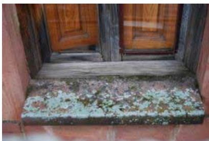
Fig. 14. Detalle de crecimiento biológico en la zona del balcón del piso intermedio, líquenes de color gris, musgos y algas de color verde y hongos de color negro, zona donde queda retenida mucha humedad. (Fuente: Fotografía de los autores)
