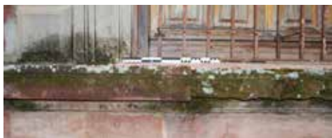
Fig. 14. Detalle de crecimiento biológico en la zona del balcón del piso intermedio, líquenes de color gris, musgos y algas de color verde y hongos de color negro, zona donde queda retenida mucha humedad. (Fuente: Fotografía de los autores)
