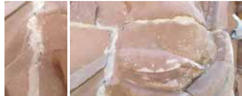
Fig. 23. Mortero de junta de sillares que en muchos casos cubren la superficie original. (Fuente: Fotografía de los autores)
