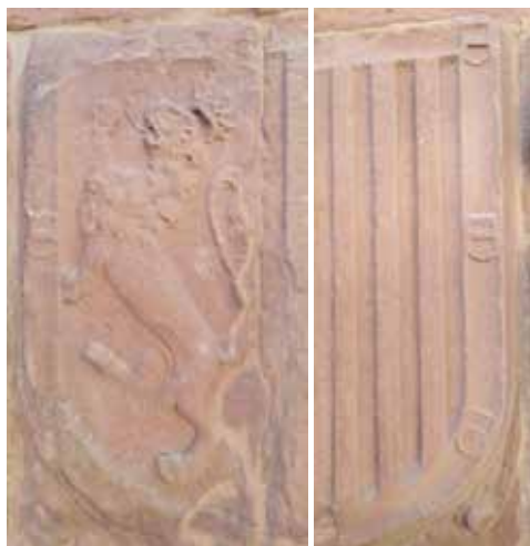
Fig. 32. Además se ha realizado el entonado de los morteros que había en el escudo, para no eliminarlos. (Fuente: Fotografía de los autores)
