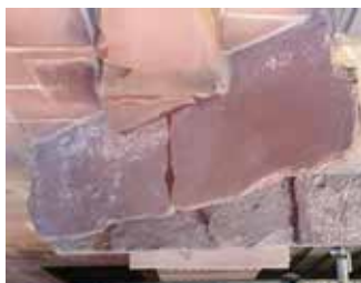
Fig. 33. Rejuntado de zonas sin mortero de junta o en mal estado de conservación. Ejemplo de rejuntado en el alero del frontón. (Fuente: Fotografía de los autores)
