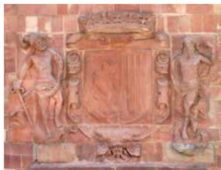
Fig. 45. Escudo después. (Fuente: Fotografía de los autores)
