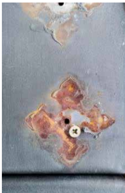
Fig. 26. Falta de barniz y sequedad de la madera, falta de clavos decorativos y oxidación del hierro por la falta de la capa de protección de metal. (Fuente: Fotografía de los autores)
