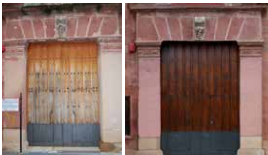
Fig. 47. Antes y después de la restauración. (Fuente: Fotografía de los autores)
