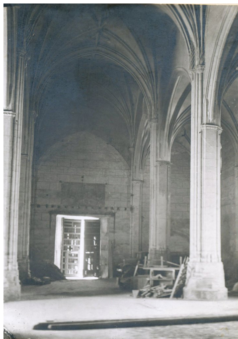
Fig. 2. Estado en que quedó la pared donde estaba instalado el órgano, con los testimonios de las vigas arrancadas. (Fuente: D a . Dolores Cabrera. Colección Blas Galey Hermoso)
